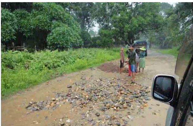
地域住民を雇用した対象道路の補修作業
