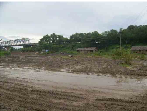
道路建設ユニット No.9 の敷地
