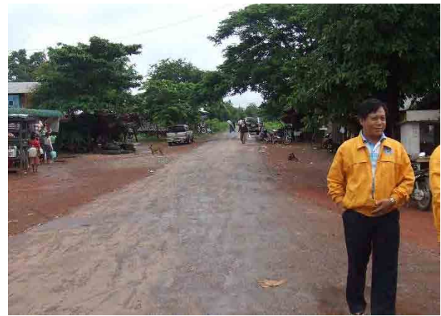
パイロット工事予定箇所
