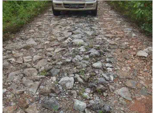
対象道路の様子
