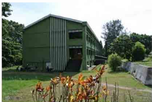
バイオテクノロジーセクション棟
