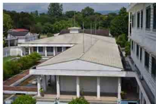
種子貯蔵施設(左平屋)・ラボ棟(右3階建てビル)
