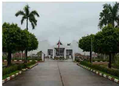
VFRDC正面玄関
