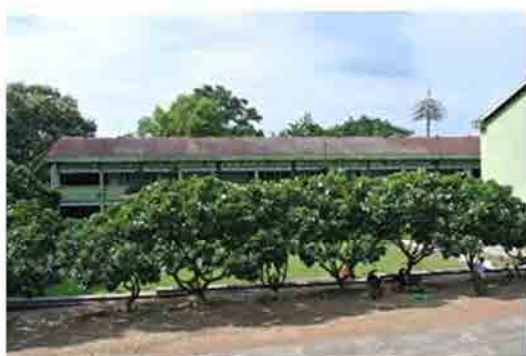
土壌科学・水利用・農業工学セクション棟
