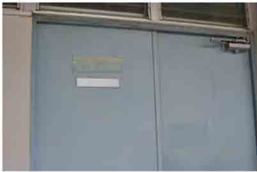
植物バイオテクノロジーラボ入り口
