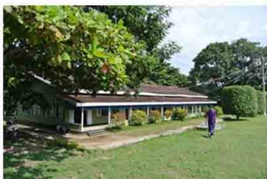
根粒菌生産ユニット棟
