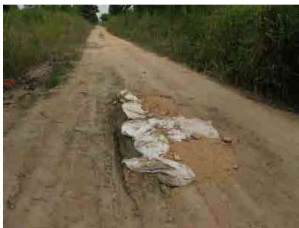
写真 7-1 自主的に「土のう」を用いて補修されたとみられる箇所
