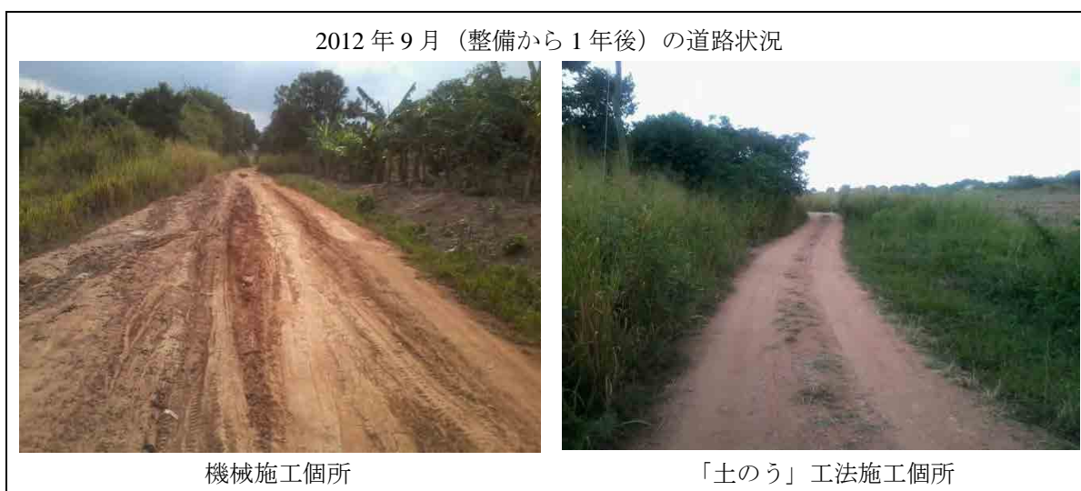
写真 6-2 機械施工個所と「土のう」工法施工個所
