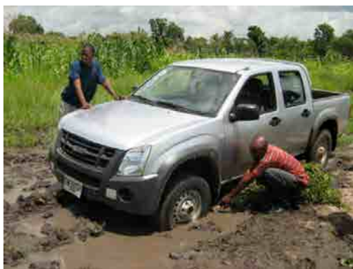
【参考写真】ガーナの地方道路（土砂道）での路面状況（このような箇所の道路補修で「土のう」は大きな効果を発揮する。）
