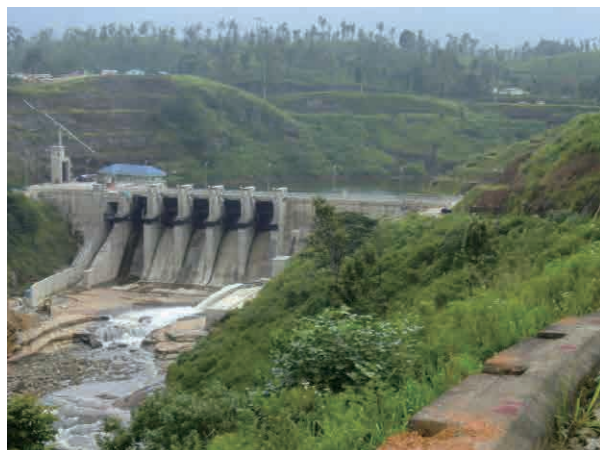
Upper Kotomale 水力発電所のダム
