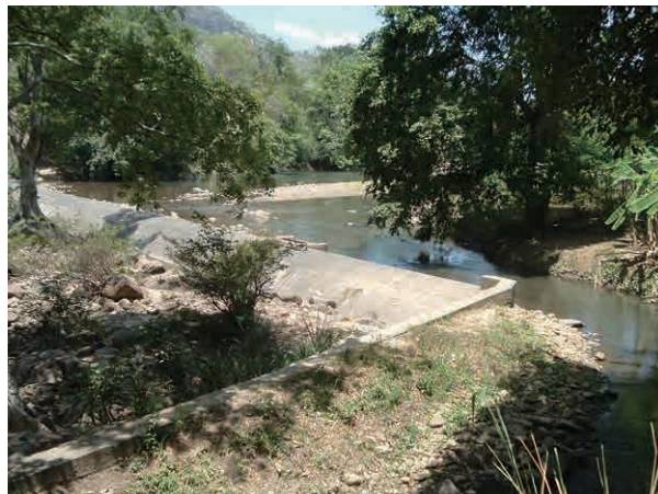
Kekale サイト下池候補地。下池候補地の下流側。取水堰がある。
