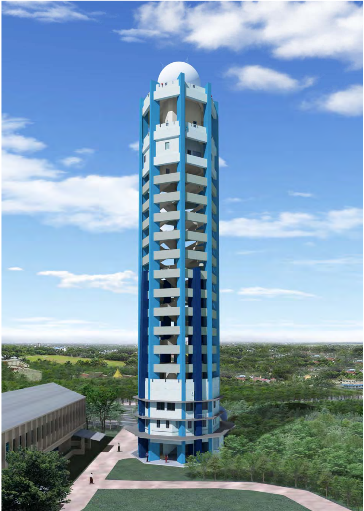
ヤンゴン気象レーダー塔施設
