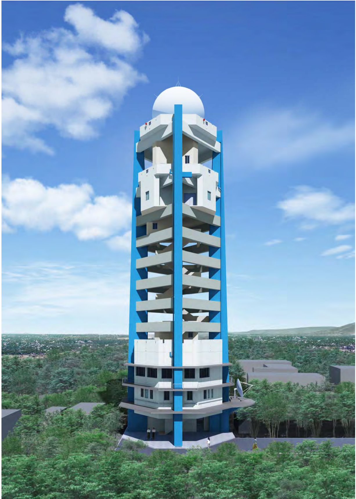
マンダレー気象レーダー塔施設
