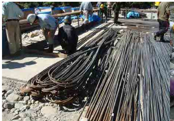
鉄筋工 8mより長い資機材は折り曲げて搬入
