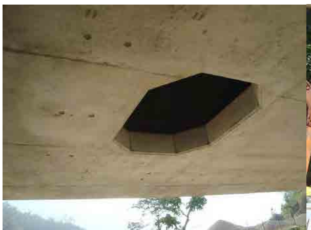
マンホールに蓋がなく開口している（各 PC 橋）
