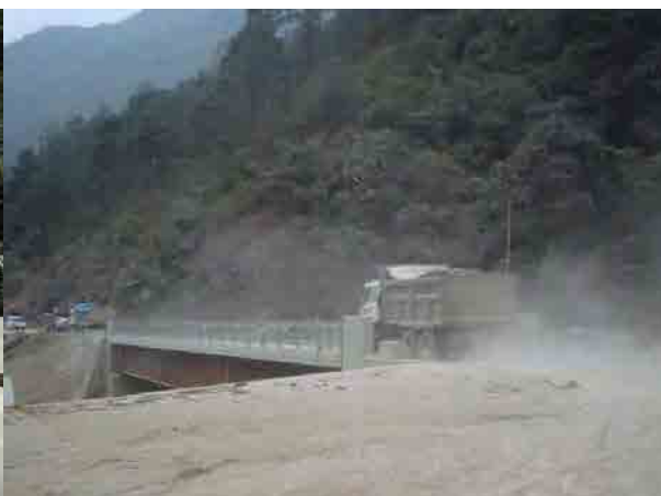
ラワカー橋の状況 工事車両が頻繁に通行し橋面と取り付け部が既に荒れている。引き渡し後も適切な維持管理が必要である。
