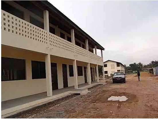
2-7 Koudoukou 校：セッション2 完工、引渡済 (2F8 教室 x2 棟、家具、備品) セッション3 着工 (1F8 教室 x1 棟、便所棟4、家具、備品)
