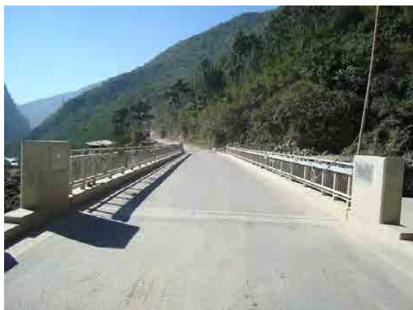
ラワカー橋の状況 工事車両が頻繁に通行し橋面と取り付け部が既に荒れている。引き渡し後も適切な維持管理が必要である。
