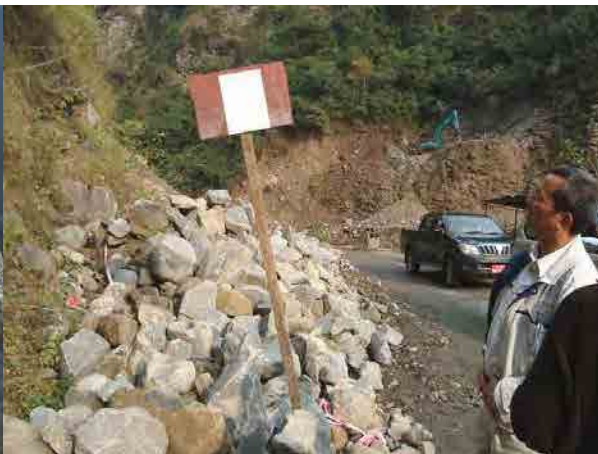
交通止め（規制時間看板） 道路改良工事による交通止め
