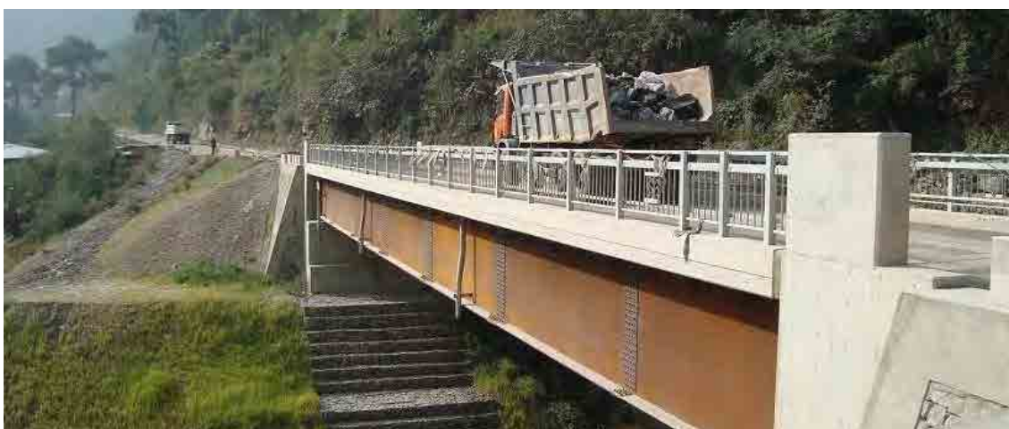
4-1 ラワカー橋 耐候性鋼版使用 L=45m 完工。2011年部分引き渡し済み。
