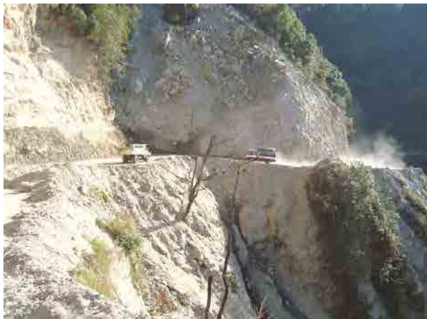
国道上の土砂崩れ地点 雨期には落石による交通止めが頻発する
