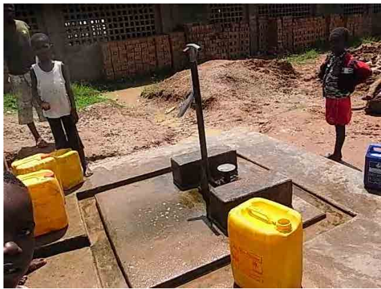
2-9 St.jean 校 (過去の無償資金協力による深井戸)：セッション2 完工 (1F3 教室1 棟、外塀) セッション3 着工 (1F3 教室 x1 棟、便所棟1)
