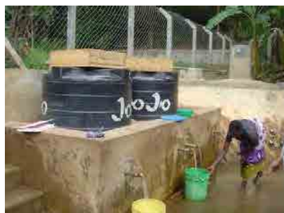
水栓はブロンズ製に交換された
