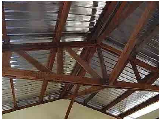
2-8 Petevo 校：セッション2 完工、引渡済 (2F8 教室 x1 棟、便所棟2、家具、備品、外塀)
