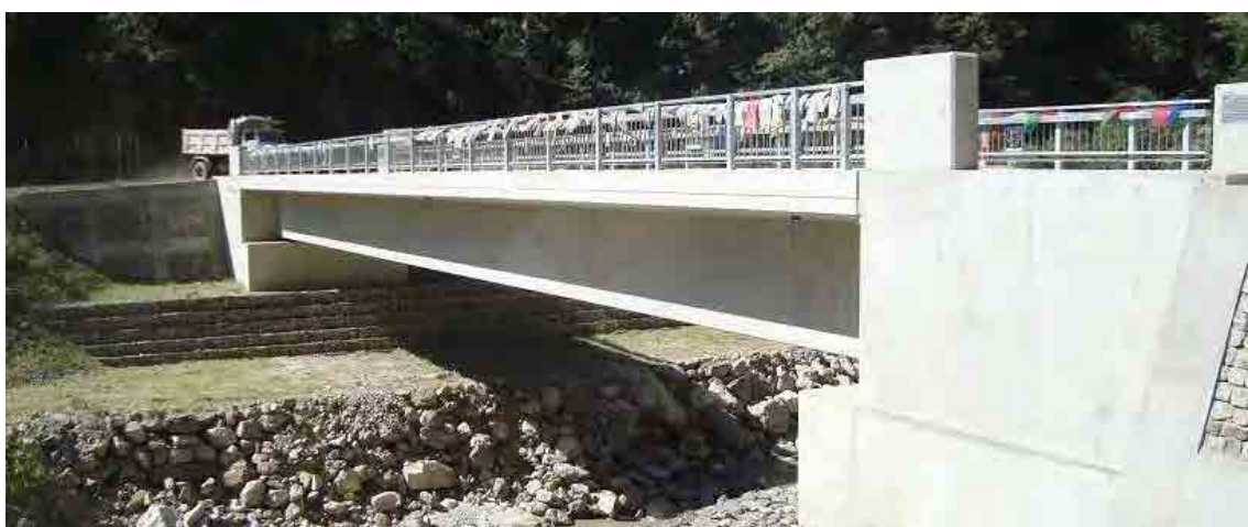
4-2 バソチュー橋 全景 PC橋 L=45m 完工。2011年6月部分引き渡し済み。
