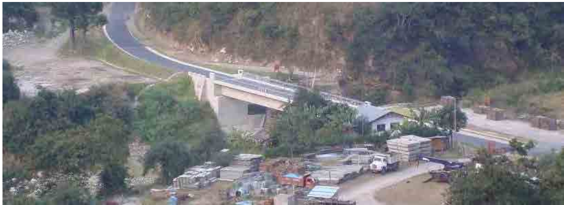
4-5 チャンチー橋 PC橋 L=45m 完工。2011年8月部分引き渡し済み。
