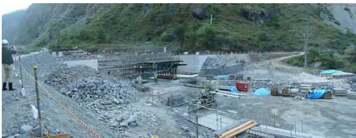
4-3 ニャラチュー橋 PC橋 L=40m 進捗 71.8% (2011年10月現在) 来年の6月からの雨期前にコンクリート工事を完了させる計画となっている。
