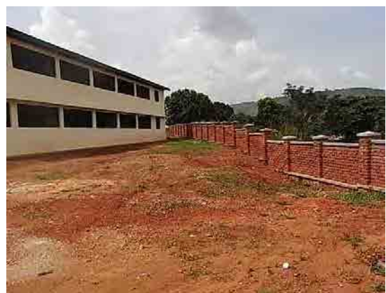
2-10 BoyRabeMixte 校 (外壁)：セッション2 完工、引渡済 (2F6 教室 x1 棟、便所棟1、家具、備品、外塀)
