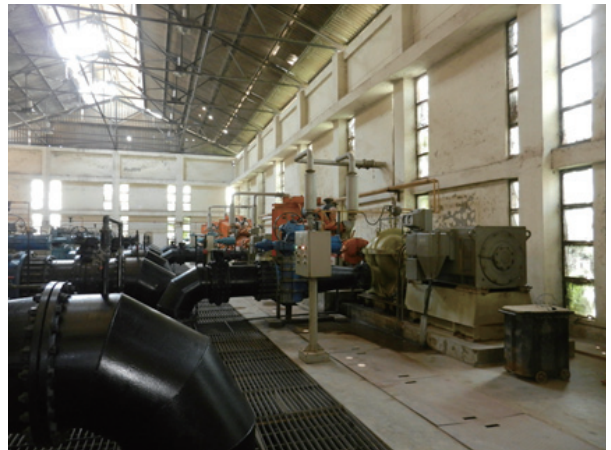
Pump Station の発電機 (ターミナル・リザーバー)
