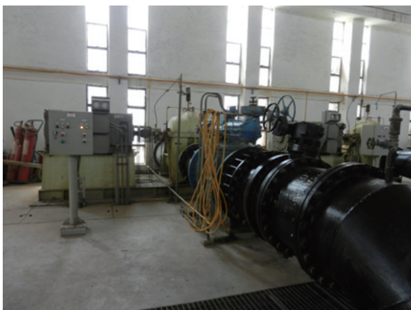
In-Line Booster Pump (両吸い込み渦巻型) (Chiniot 加圧ポンプ場)
