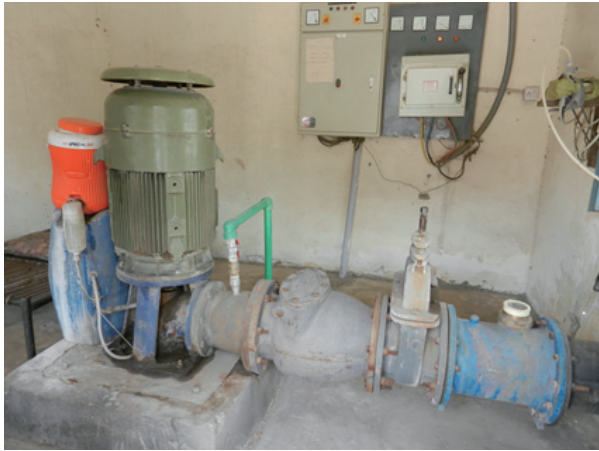
深井戸ポンプ No.64 (パ国 KSB 社製)
