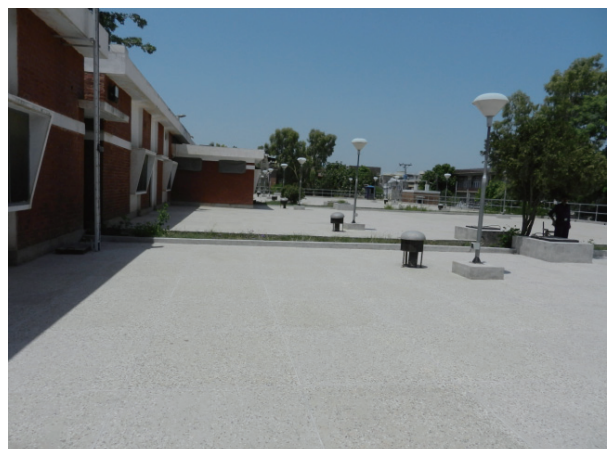
ターミナル・リザーバー (送水管終点)
