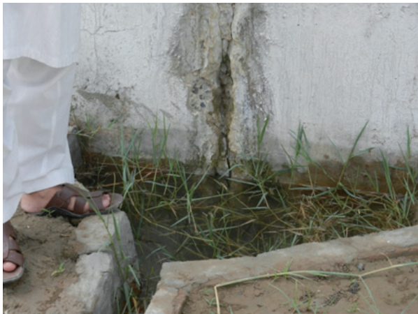
伸縮継ぎ目からの漏水 (ターミナル・リザーバー)
