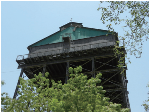
鋼製高架水槽 (400,000G:H \approx 30m、1932年)
