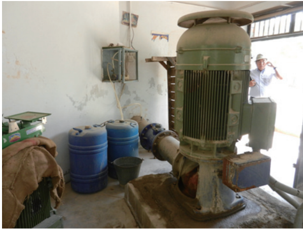
深井戸ポンプと塩素滅菌装置 (全井戸塩素滅菌)
