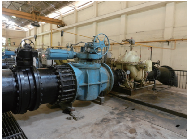
Pump Station の両吸い込み渦巻型ポンプ (ターミナル・リザーバー)
