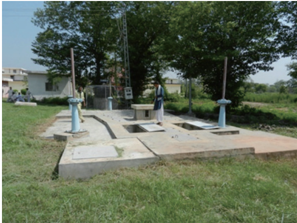
ラワル (Rawal) 浄水場内の送水分岐ピット (送水管始点)
