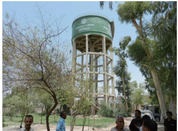
深井戸敷地内の RC 高架水槽 (H \approx 20m)
