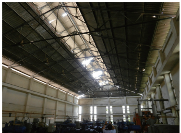
Pump Station の破損屋根 (ターミナル・リザーバー)
