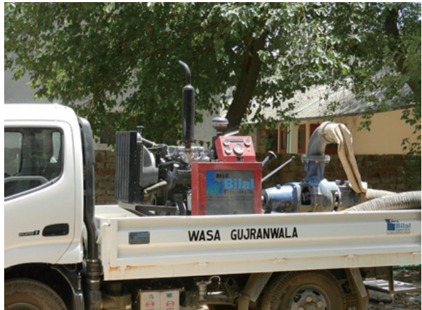
市内資機材置き場の移動式発電機と排水ポンプ
