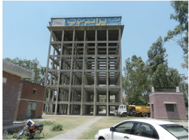
既存高架水槽 (300,000G:H ≒ 25m)
