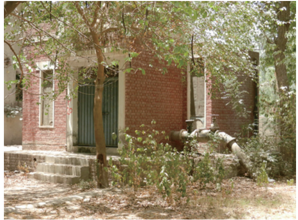
井戸送水管 ( \phi 250 亜鉛メッキ鋼管)
