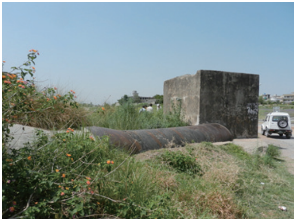
既設送水管サイホン部 (サイホン部は鋼管)
