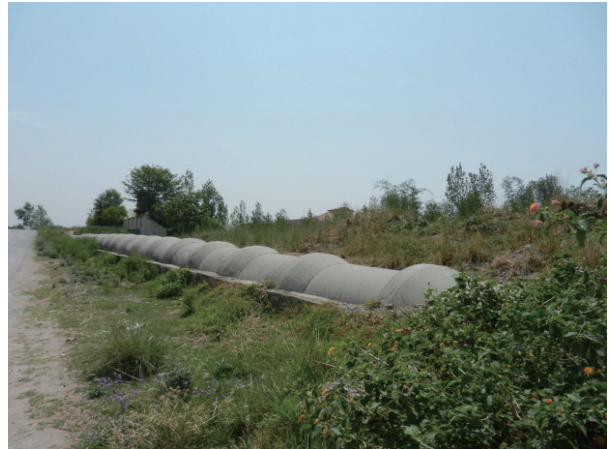
漏水が多く廃棄された RC 送水管 (ターミナル・リザーバー)
