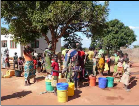
写真1 2011年に建設されたMavago郡手押しポンプ井戸
