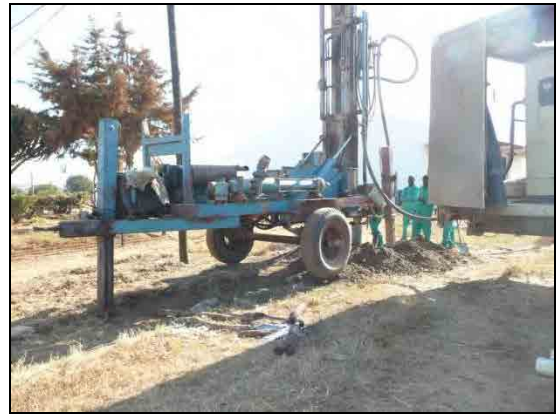
写真2 ニアッサ州唯一の井戸掘削業者
