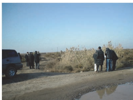
イミシュリ 機能喪失排水路 SD-11-1 (埋まった水路とアシ繁茂)
