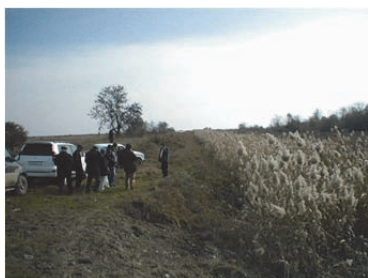
K-36 系統カテゴリ3 排水路状況
