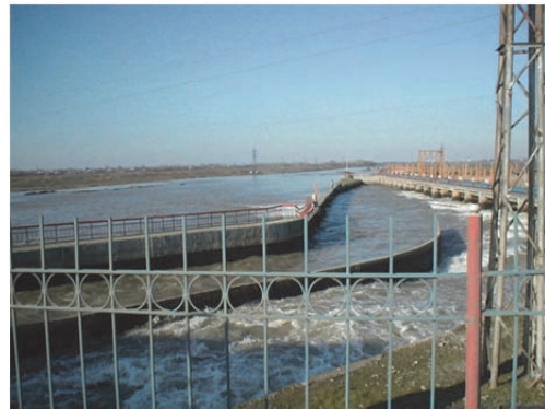
バフラム・テペ頭首工 取水工付近
