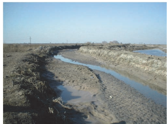
イミシュリ 用水路への土砂堆積(アラクス川取水) 圃場への灌漑水導入状況
