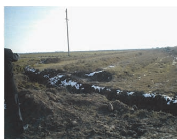
R-7 系統分水後の機能喪失用水路 (中央:カテゴリ3)と仮廻し
