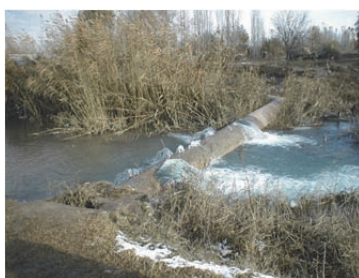
R-14 用水路下流での補水
