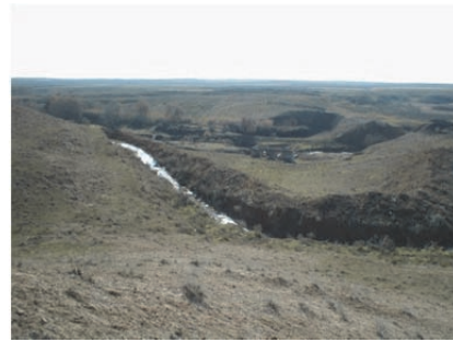
フィズリ アラクス川支流ミザカマリ川 灌漑施設 水路状況
