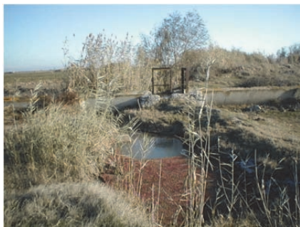
ベイラガン カラー用水路 (旧取入口と補水用コンクリート水路)
