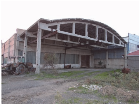
整備工場建屋
