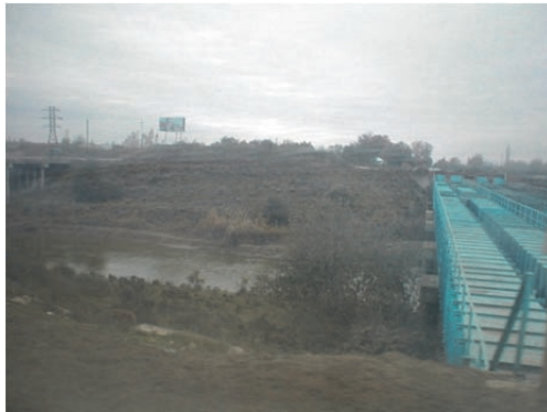
ミル・ムガン コレクタと カラバフ幹線水路の水路橋
