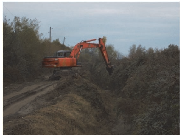
タイヤ式エクスカベータ(0.8m 3 ) 排水路の掘削工事中、15,000時間稼働 (フェーズ1調達機材)
