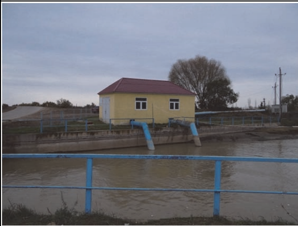
灌漑用水のポンプ場 灌漑用水を農地へ送るため、アラクス川の水を揚水している
