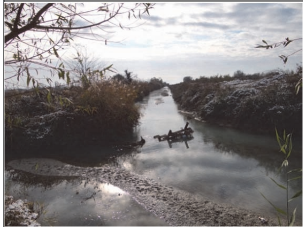
取水工付近の堆積状況(アグジャベディ地区) 地区上流部のため土砂の堆積が極めて多い。この水路の下流では、幹線水路から別途取水している
