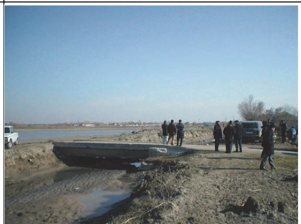
用水路の堆積状況(イミシュリ地区) アラクス川からの取水のため砂分の堆積が多い
