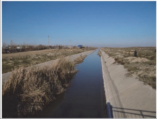
幹線水路の状況(フィズリ地区) 下流方向に向かい、右岸側を浚渫、左岸側には土砂堆積が残っている
