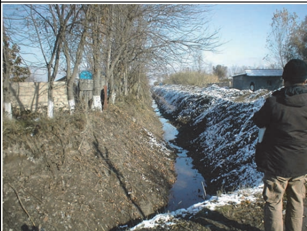
掘削直後の排水路(アグジャベディ地区) 水路深さの確保に重点を置いて掘削している
