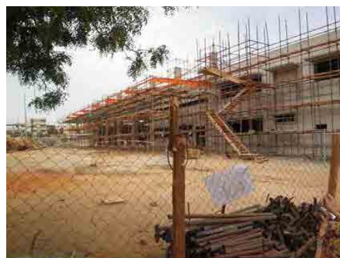
写真 5-1：建設中の新校舎
