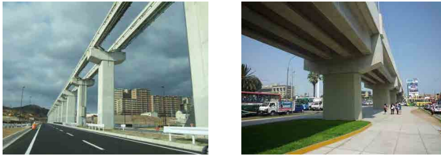
Figura 6.12 Superestructura de Monorriel y Estructura Convencional de Losa
