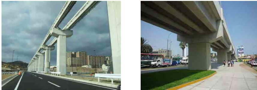
図 6.5 モノレールの軌道構造と通常のスラブ構造
