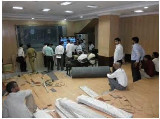
構築中センター内の様子
