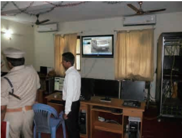
監視室内の様子
