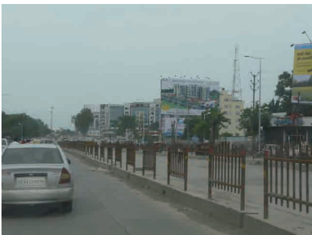
BRTS レーン (供用予定)
