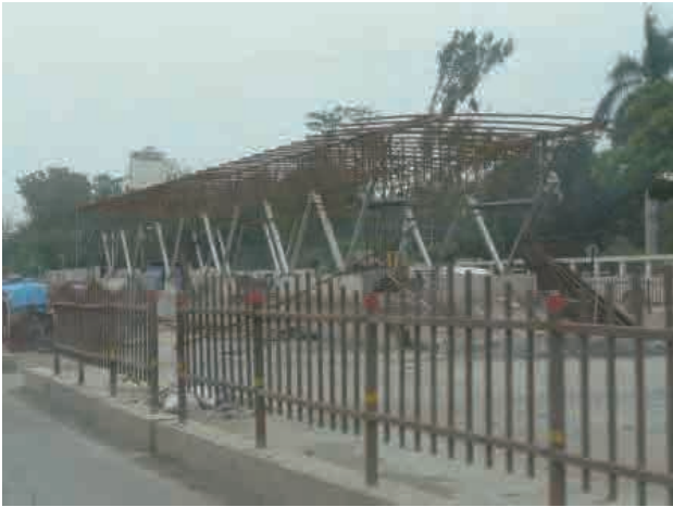
建設中 BRTS 設備 (バス停)
