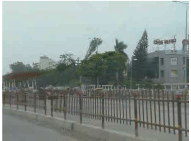
建設中 BRTS 設備 (専用レーン)
