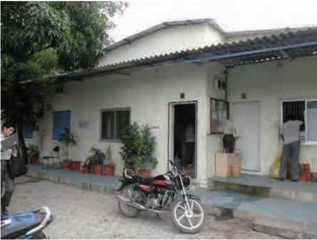
運行管理室 建物
