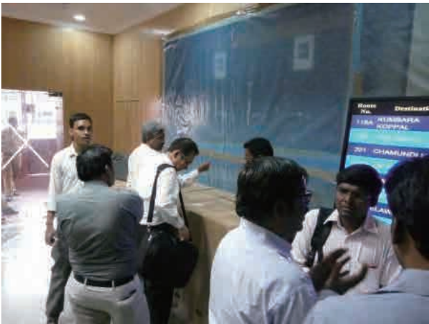
構築中センター内の様子
