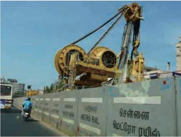
チェンナイメトロ建設現場
