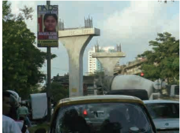
モノレール建設現場
