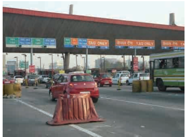
デリーーグルガオン道路 料金所 (ETCゲート：Passive DSCR)
