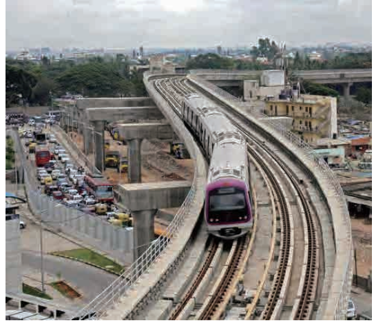
メトロ車両と高架橋
