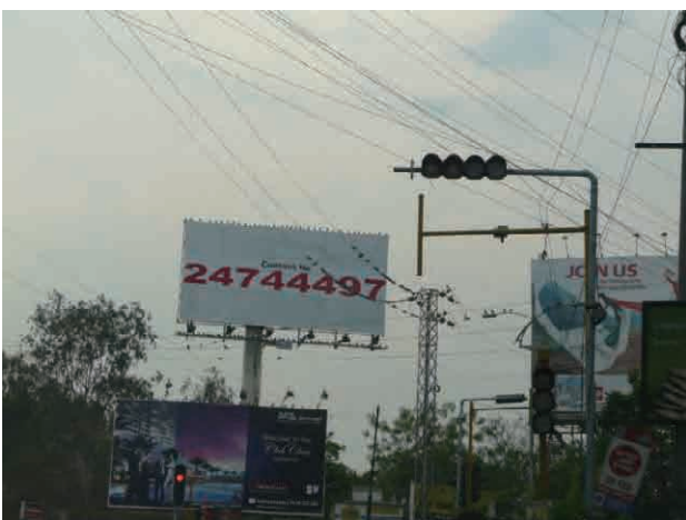
故障中の信号機
