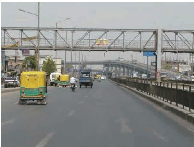
歩道橋（手前）と高架橋（奥）
