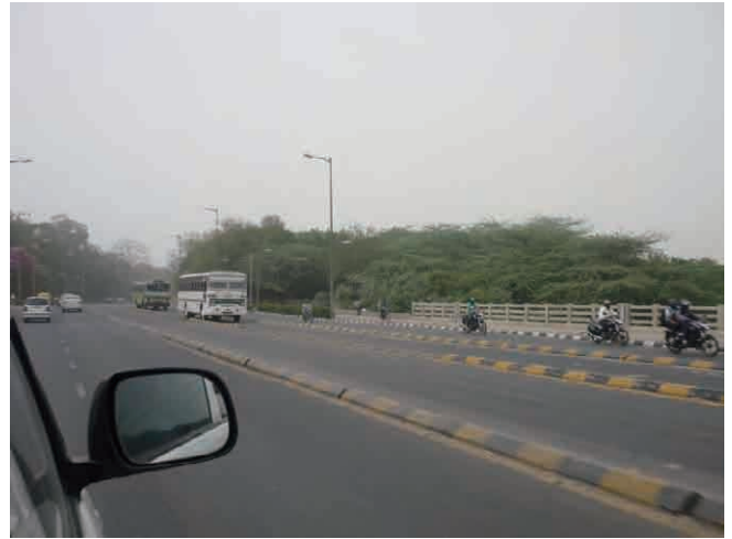
BRTS 専用レーン
