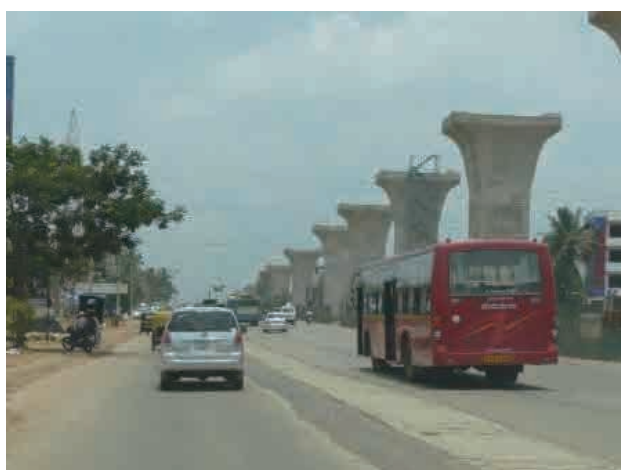
メトロ建設現場（延伸）
