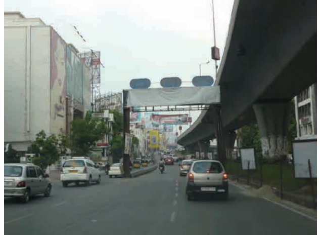
高架橋と側道
