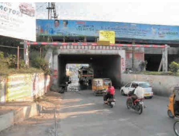
鉄道アンダーパス（常時冠水地点）
