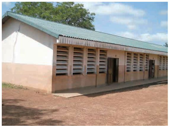
写真-27:我が国の援助 (第2次) による校舎 外観 プレキャストコンクリートのルーバー窓採用 イエタポ, ナティティング
