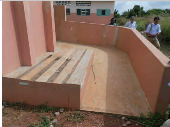
写真-36: 我が国の援助（第4次）のトイレ棟 に設置されたスロープ ソドウメ / B, ボイコン, ズー県
