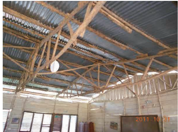
写真-10：丸太を利用してトラスを組んだ教室 No. 26 ヨコシ / C, ナティティング
