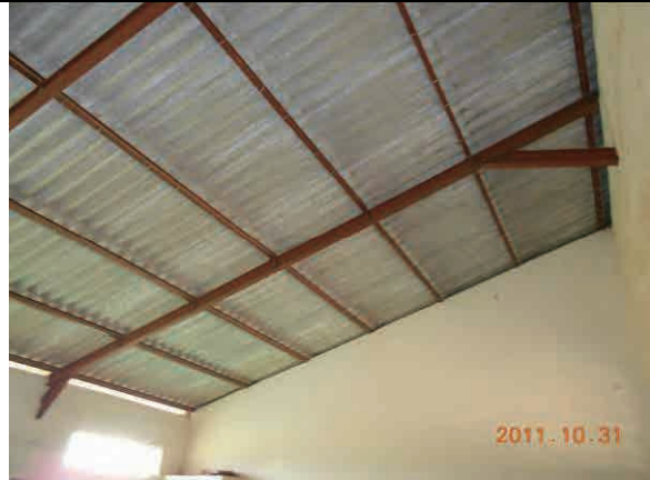
写真-26: BID 案件の内部 鉄骨材の屋根下地を使用, No. 27 ウルブガ / C
