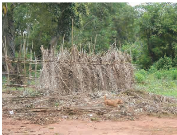
写真-18：藁で作った簡易トイレ ミトロ / A (第4次), ダンボ, ウエメ県
