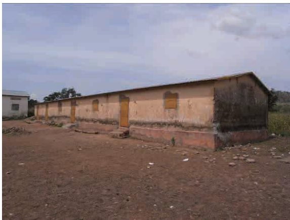
写真-5 : バンコ (日干し煉瓦) の校舎 No. 34 マモサ, タンギエタ
