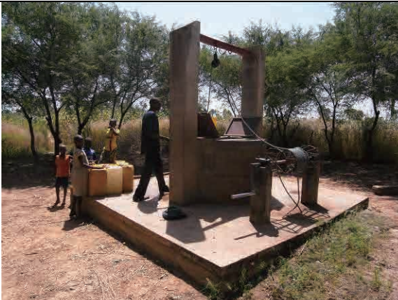
写真-42: 学校の敷地に設置されている井戸 No. 20 クンペウン, マテリ
