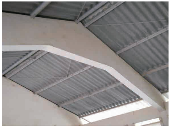
写真-28: 我が国の援助 (第2次) による校舎 内部 鉄筋コンクリートの登り梁を採用 イエタポ, ナティティング
