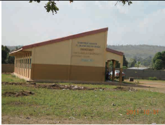
写真-25:イスラム開発銀行 (BID) 援助の建物 片流れの屋根を採用, No. 27 ウルブガ / C
