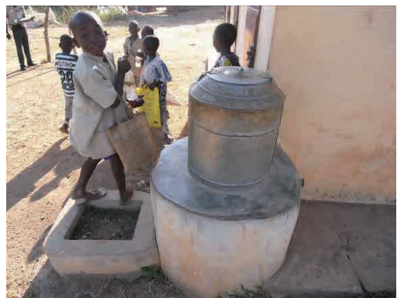
写真-16： トイレ横に設置された手洗いタンク 水は運んでくる必要がある No. 47 バトゥルー / D, ジョグー
