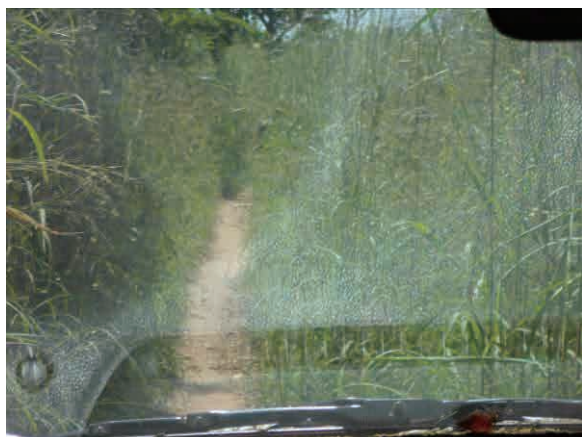
写真-24：四駆ならばかろうじて通行は可能だが、工事車両の通行は不可 No. 5 クエタクアング, ブクンベ
