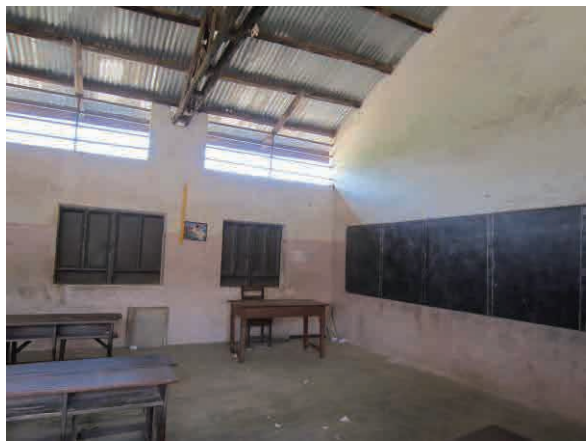
写真-8：教育省標準設計の校舎の内部 屋根と壁の間が大きく開いていて盗難にあう ケースがあるため、柵を設けている学校がある。 No. 13 ギルマロ / B, クアンデ
