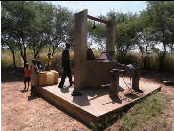
写真-42: 学校の敷地に設置されている井戸 No. 20 クンペウン , マテリ
