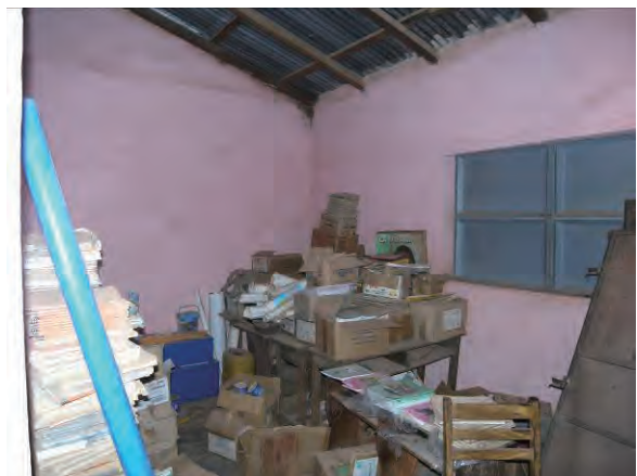
写真-12：校長室横の倉庫内部 教材、教科書等が保管されている No. 47 バトゥルー / D
