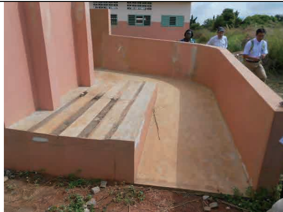
写真-36: 我が国の援助 (第4次) のトイレ棟 に設置されたスロープ ソドウメ / B, ボイコン, ズー県
