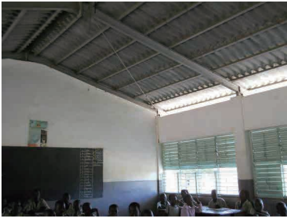
写真-31: 我が国の援助 (第3次) による校舎内部 鉄骨屋根下地材を使用 アベオクペ, パシラ
