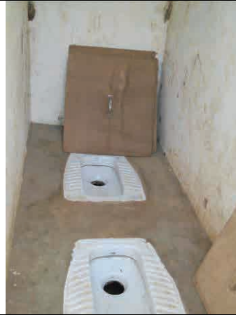
写真-32: 我が国の援助 (第3次) によるトイレ内部 第2次とは違い、陶器の便器が設置されている EUC クアンデ / B, クアンデ
