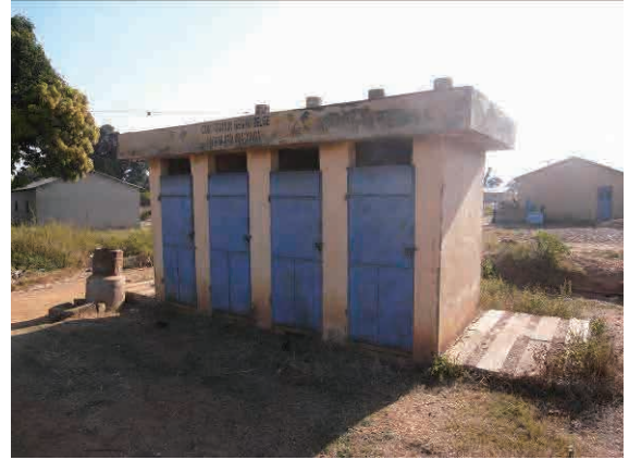
写真-14： トイレ外観 No. 47 バトゥルー / D, ジョグー
