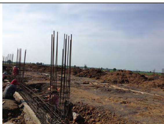
新しい精米工場建設中
