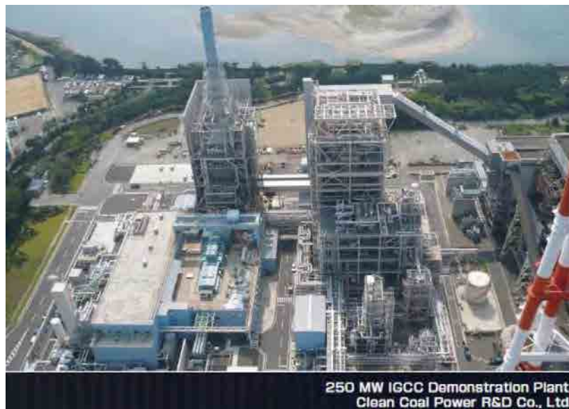
写真 5.2-1 250MW の IGCC デモ・プラント
