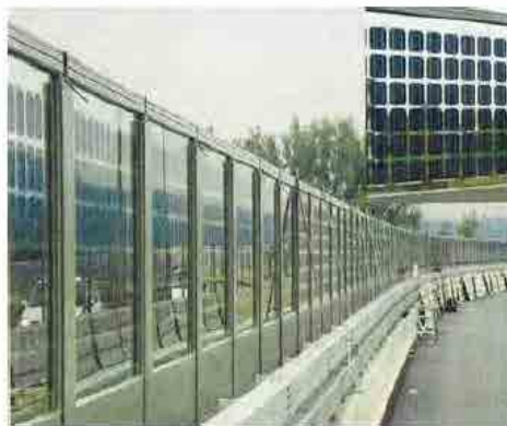
写真 5.1-2 日立製作所製両面受光型太陽電池の設置例
