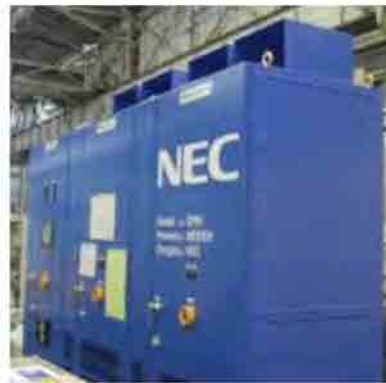
図 5.3-6 NEC 製リチウム・イオン電池電力貯蔵設備
