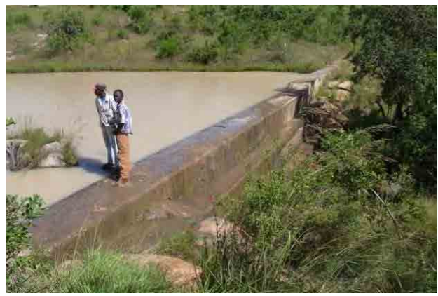
写真2： タナ川流域でコミュニティが、水資源管理庁の支援・指導の下、建設したチェックダム
