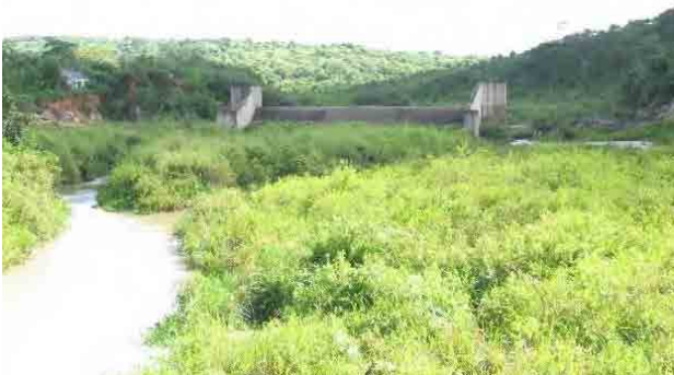
写真5： コースト WSB で、AFD 資金で改修される予定の上水用取水堰
