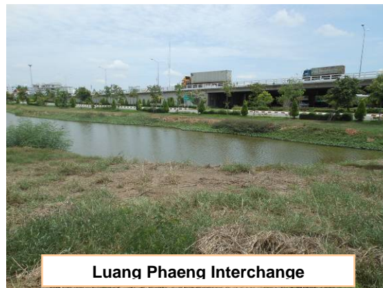
写真 3-2-4-2.1 インターチェンジ全景
