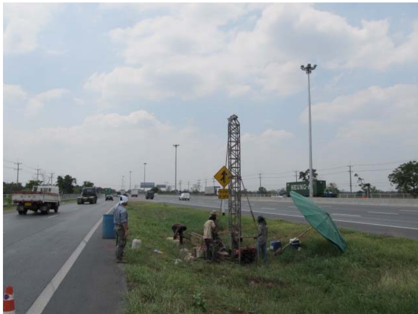
写真 3-2-1-2.1 現場ボーリング試験状況
