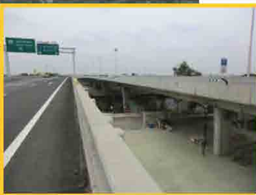
高架橋(Sta.22km 付近)
