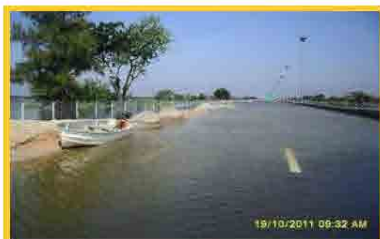
2011年洪水時 対象道路冠水被害状況
