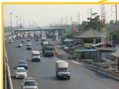
北方向料金所付近全景 Sta.24+875 ~ 25+600
