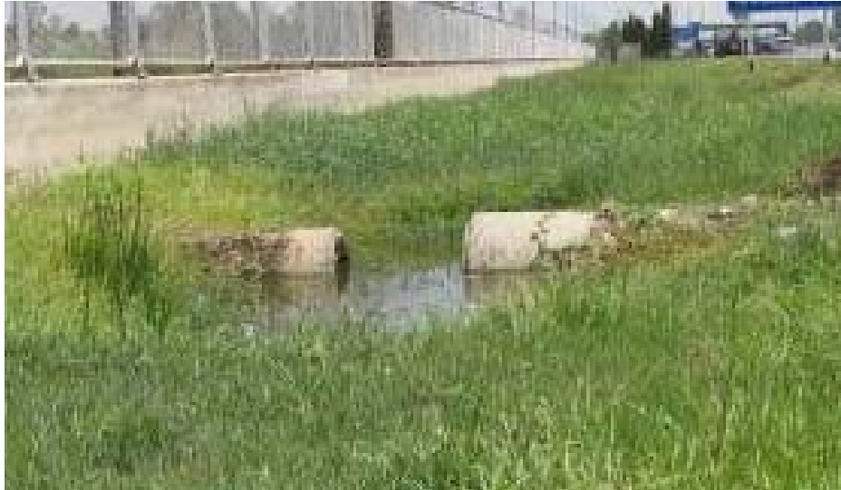
写真 3-2-1-2.2 既存施設の現況調査（境界柵内側設置の自然集水・吐口構造）
