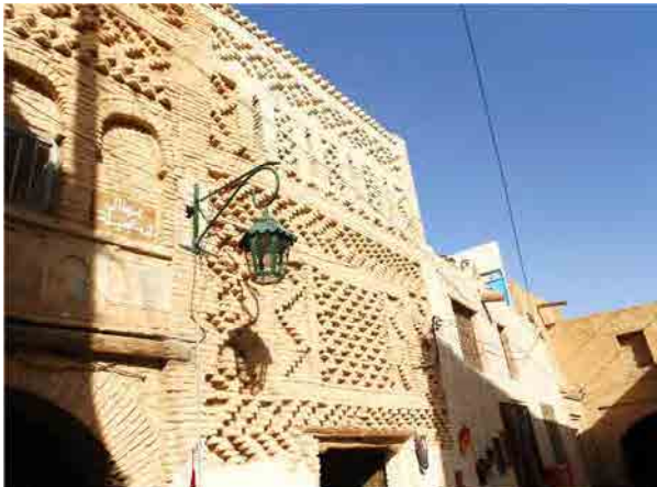
トズール市内の伝統的な 日干しレンガを用いた建築物
