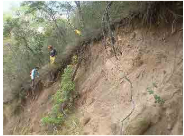
Secuela de derrumbamiento en la parte más alta, Precipicio de h=3-5 m
