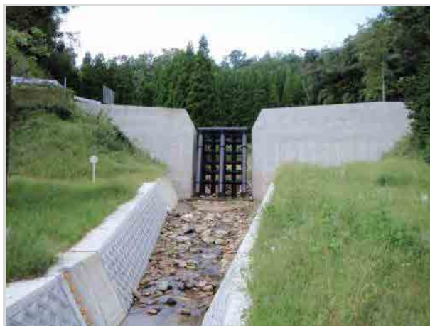
Figura 2-21 Ejemplo de un dique permeable
