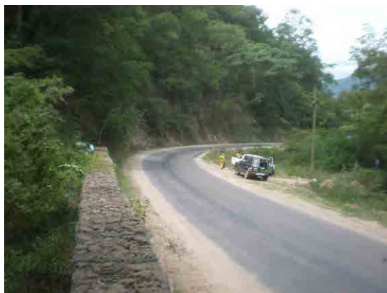
Parte superior del gavión existente
