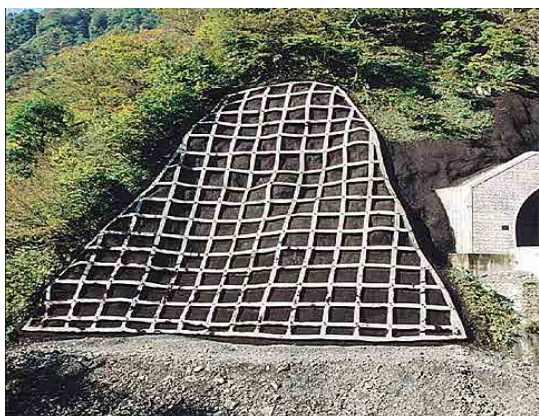
Marco de hormigón proyectado
