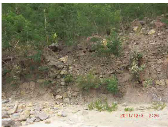
Medida de sujeción por gaviones
