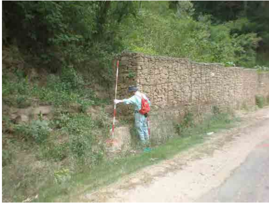
Obra del gavión existente
