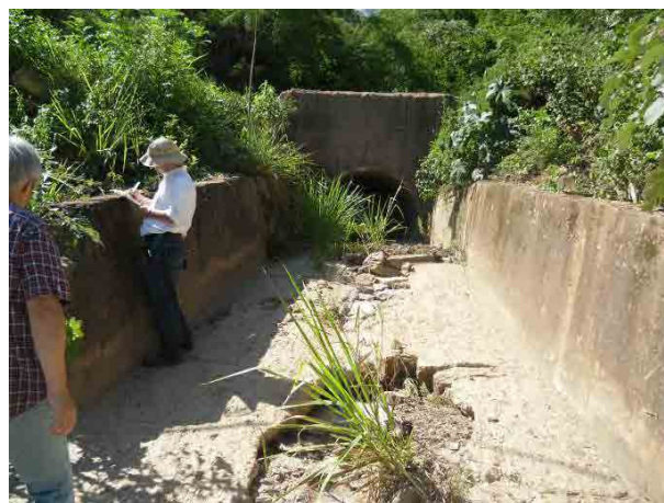
図 3-16 07-03地区下流コンクリート3面張り水路状況
