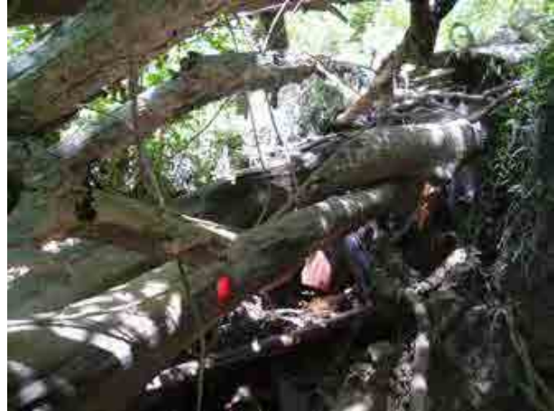
流木堆積状況（河床部）
