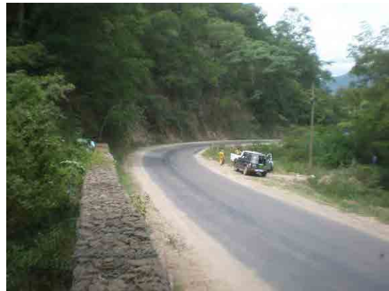
既設ガビオン工天端部
