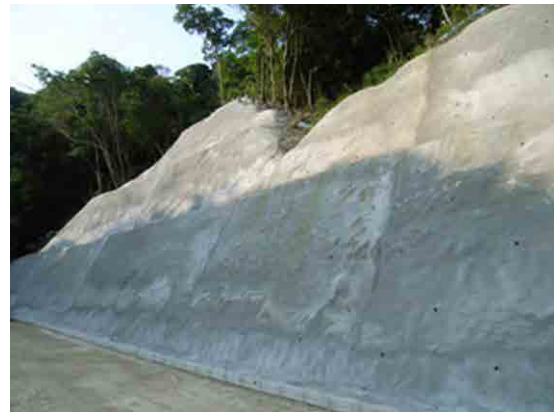
図 3-53 「ボ」国で実施されている斜面对策工の例
