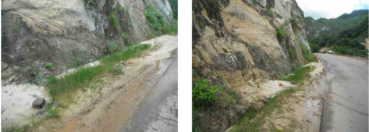
図 3-10 07-02 地区の雨期後の斜面状況
