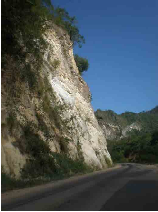
路側部の状況
