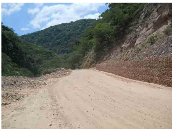
図 2-5 線形改良による対策工（07-07 地区）
