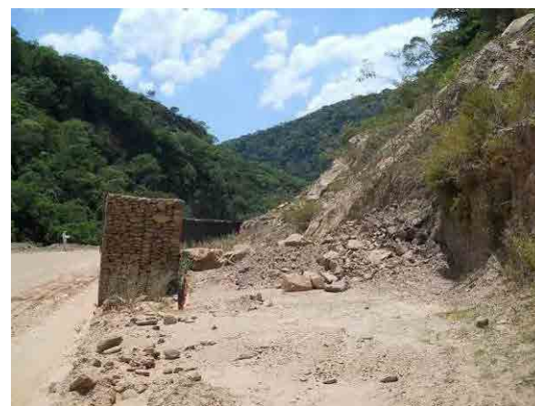
図 2-5 線形改良による対策工（07-07 地区）
