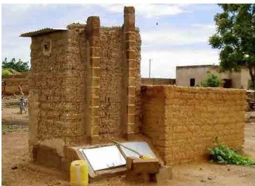
写真-23 日干し煉瓦製 ECOSAN トイレ 日干し煉瓦製の廉価版の ECOSAN トイレ。隣接する堀 の囲いは水浴び場。尿と糞便は分離されて、尿はジェ リ缶に貯められる。
