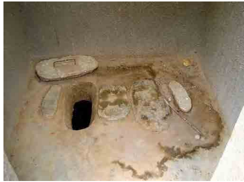
写真-18 左記の小学校トイレの足場 2 槽式 VIP トイレで、便槽が 2 つあり、片方は閉めて ある。
