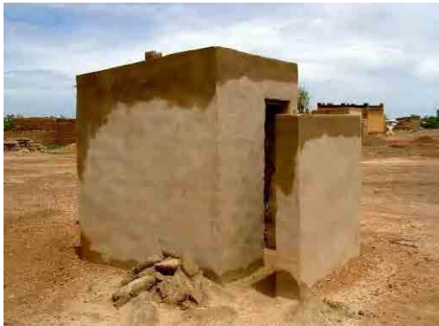
写真-21 家庭用の単槽式 VIP トイレ AfDB の資金で、現地 NGO の CREPA が左官の訓練時 に建設した家庭用の単層式 VIP トイレ。2007 年 2 月か ら 207 人の左官と 268 人のアニメーターを養成中。
