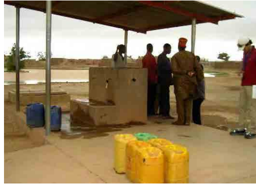
写真-2 Mogtédo 村の公共水栓 公共水栓 10 箇所所で約 12,000 人に給水している。水料金は 10\text{Fcfa}/20\text{l} で、売り上げの 20% が公共水栓の管理人の取り分。運転は民間オペレーターに委託している。
