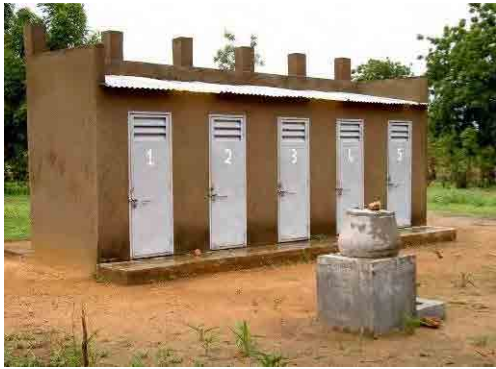
写真-17 DANIDAによる小学校トイレ ガンズルグ県 Zam コミューン Lapadma 村。DANIDA により 2003 年 1 月に建設された小学校のトイレ。前庭 に手洗い用のコンクリート製水桶があるのが特徴。
