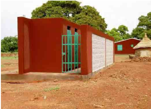
写真-19 日本の無償資金協力による小学校トイレ クルウェオゴ県 Sourgoubila コミューン Meko 村小学校 のトイレ。2007 年に我が国の無償資金協力により建設 された。2 槽式 VIP トイレ。
