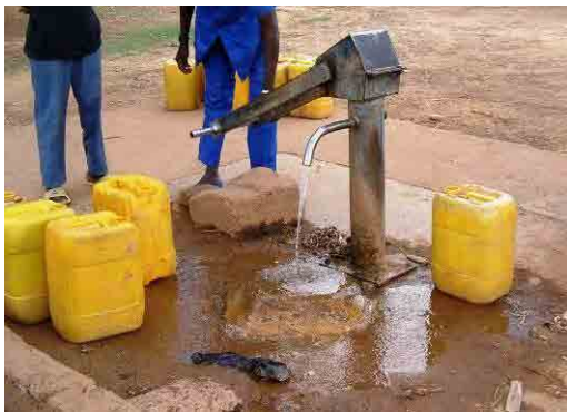
写真-5 Zitenga 村の DIAFA 型人力ポンプ ウブリテンガ県 Zitenga コミュニティ Zitenga 村の DIAFA 型人力ポンプ。1987 年建設で古く年に数回故障。分担金として、既婚者の男女から 100\text{Fcfa}/\text{月} を徴収している。
