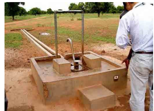
写真-8 日本の無償資金協力による小学校の人力ポンプ クルヴェオゴ県 Sourgoubula コミュニティ Meko 村小学校の Vergnet 足踏みポンプ。2007 年に我が国の小学校建設の無償資金協力により建設された。
