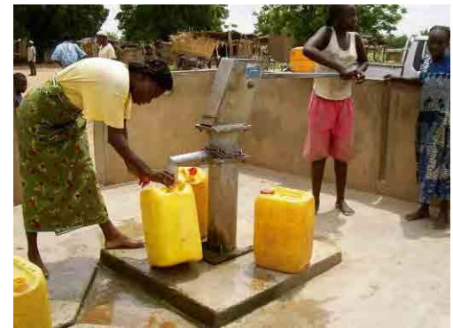
写真-6 Zam 村の India-Mk II 型人力ポンプ ガンズルグ県 Zam コミュニティ Zam 村の India-Mk II 型人力ポンプ。雨季の 4 ヶ月間は既婚女性 1 人あたり 500\text{Fcfa} (1 回) で、乾季は 5\text{Fcfa}/20\text{l} の水料金。裸足で入る規則。
