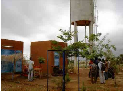
写真-1 Mogtédo 村のレベルII 給水施設 ガンズルグ県 Mogtédo コミュニティ Mogtédo 村。DANIDA が 2003 年に建設したレベル II 給水施設。揚水量は 7\text{m}^3/\text{h} 、給水塔は 45\text{m}^3 。発電機の故障が多い。
