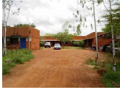
写真-34 農業・水利・水産資源南部中央地方局 Mangaにある農業・水利・水産資源南部中央地方局の建物。
