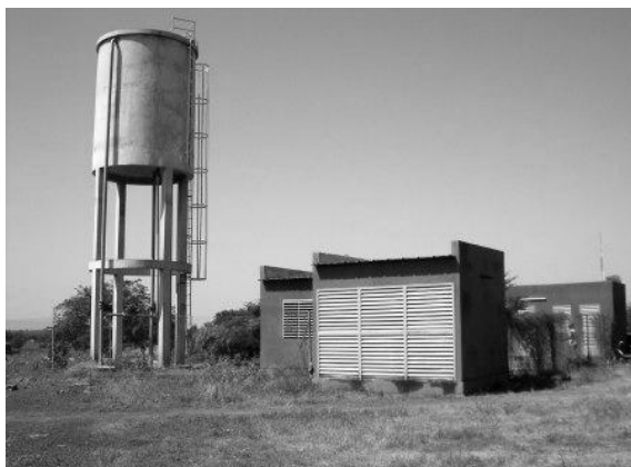
図 4-6-1 AEPS の給水塔と発電施設・管理棟
