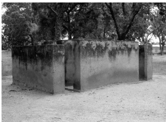
簡易ピット式の公衆トイレ
