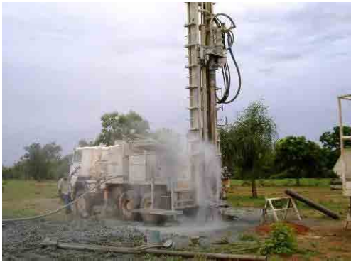
写真-3 深井戸掘削現場 ガンズルグ県で実施中の UNICEF の村落給水プロジェクトの深井戸掘削現場。業者は現地企業の Forafrique 社で、フランスの FORACO 社製のリグ 8 台を所有。
