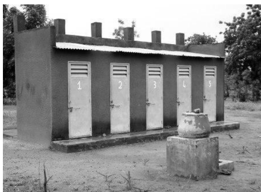
DANIDAによる小学校の二槽式VIPトイレ
