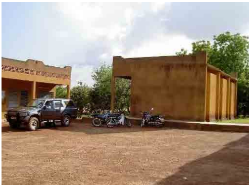
写真-37 農業・水利・水産資源ウブリテンガ県支局 Ziniaréにある農業・水利・水産資源ウブリテンガ県支局の建物。パソコンは地方局から借りて使っている。車両はピックアップ1台のみで、モーターバイクはない。
