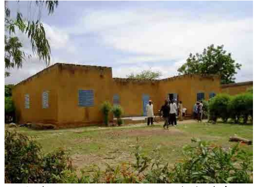
写真-26 Zam コミューン（郡）庁舎 ガンズルグ県 Zam コミューンの庁舎は未だ無く、現在郡の庁舎を借りている。
