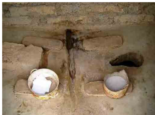
写真-24 ECOSAN トイレの足場構造 2 槽式で片方は閉めて、6 ヶ月ごとに交代で使う。尿と 糞便は分離され、便にはハエ防止用に灰を撒く。尿は 肥料として、糞便はコンポストとして使われる。
