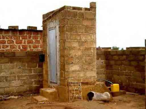
写真-22 コンクリートブロック製 ECOSAN トイレ スウェーデンの資金で CREPA がカディオゴ県 Saaba コミュニティに 62 箇所の ECOSAN (ECOLOGICAL SANitaion) トイレを建設した。高床式で便槽が地表に あるのが特徴。
