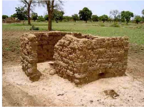
写真-20 伝統的な家庭のトイレ クルウェオゴ県 Sourgoubila コミューン Natenkodogo 地 区。伝統的な家庭用の単槽式トイレで、壁は日干し煉 瓦。便槽が既に満杯のため、放棄されている。
