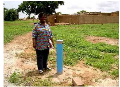
写真-4 JICA の B/D による試掘井 実施中の BD において、ガンズルグ県 Zam コミュニティの中心地区で実施された試掘井。2 本中 1 本が成功し、レベル II 給水施設用の水源井戸として仕上げられた。
