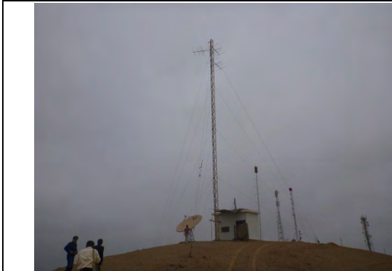
デジタル TV 送信所建屋（カニエーテ局） ISDB-T 送信機の設置場所。ここからデジタル TV 受信機に防災情報が送られる。
