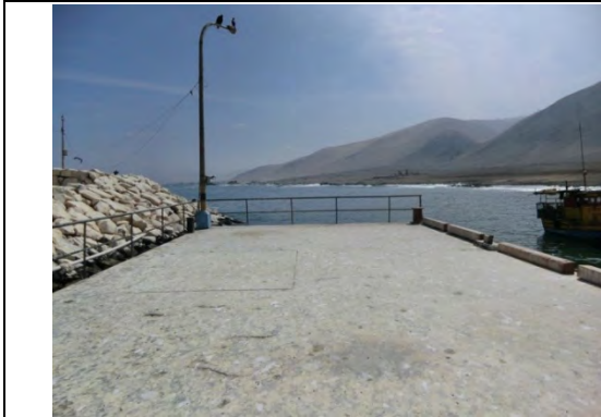
潮位計設置可能サイト(カレタグラウ) 障害物や高潮が無く安定した潮位計測が可能。機材据付のための基礎も強固である。
