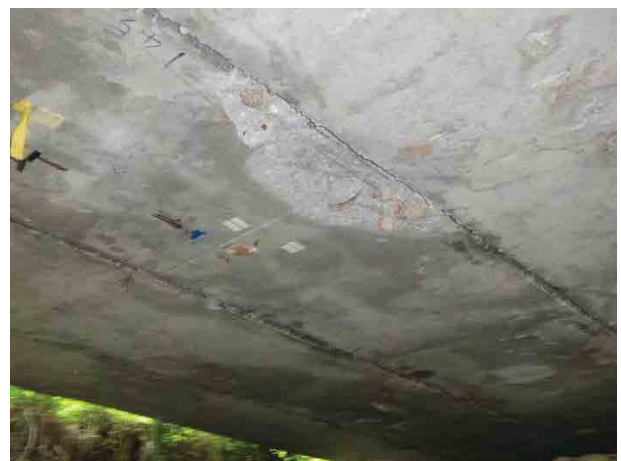
PC 桁の割れ。PC 鋼材が露出している。
