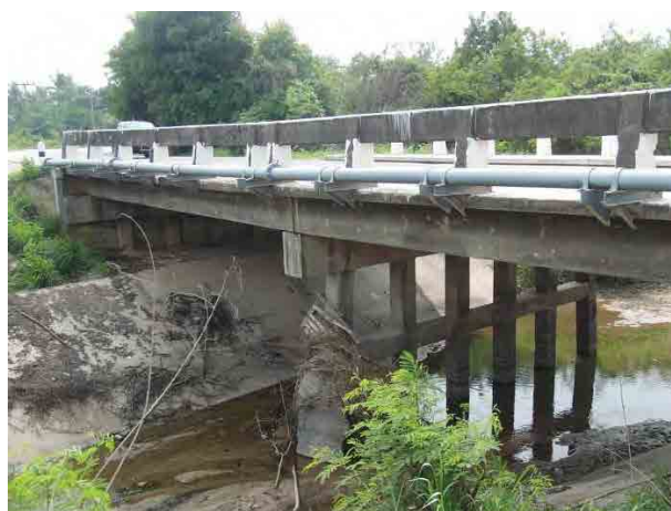
Saphan Kham Khlong Huai Kru 橋 (2010 年に灌漑局より移管された橋梁。中 間橋脚が沈下し、路面が沈下している)
