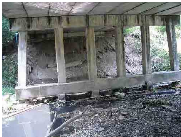
中間橋脚は河川に 60 度程度、かつ角杭による複数の橋脚（標準設計）を持つ
