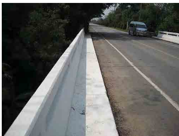
路面の塗装は頻繁に補修が行われており、良好。
