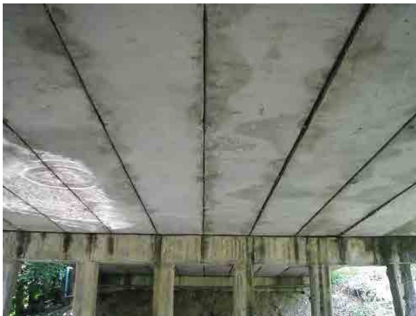
PC プレキャスト桁の隙間、伸縮位置から漏水の跡が多い。
