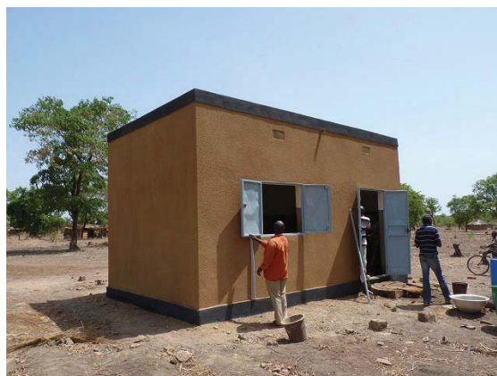
プロジェクトで設置した倉庫
