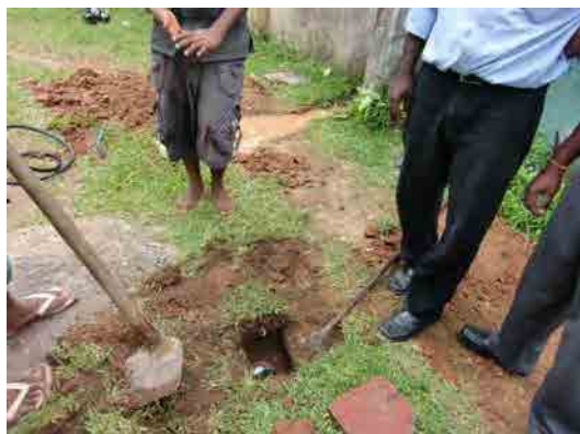
Borella メーター調査 (埋まったメーターを掘り起こしている)
