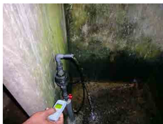
Kotahena 公共水栓へのメーター設置
