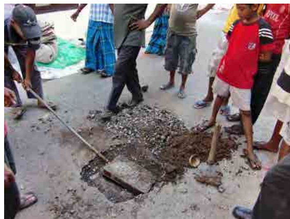
Kotahena バルブ探査
