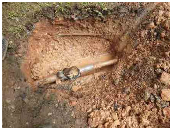
パイロット活動（Kotahena） （漏水管の掘削）
