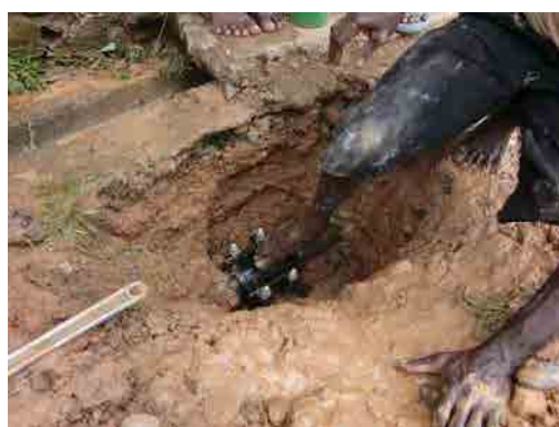
Borella 漏水補修
