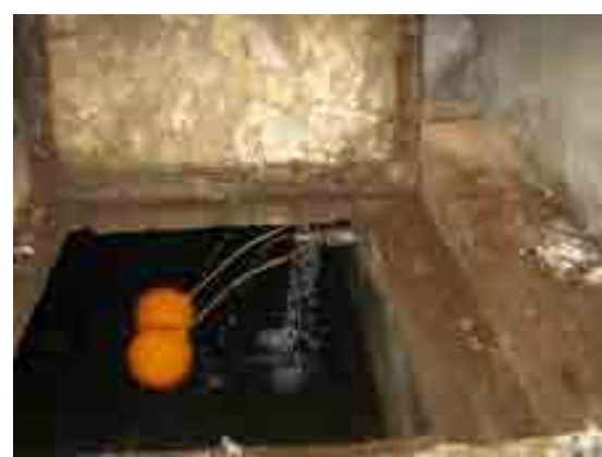
パイロット活動（Borella） （集合住宅 sump のフロート弁改善作業）
