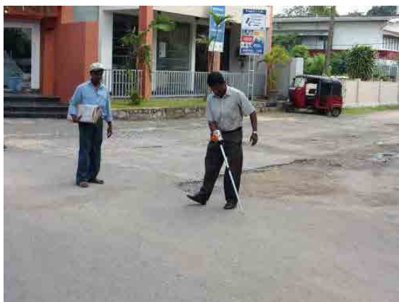
Kotahena バルブ探査
