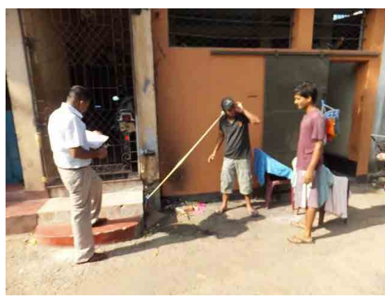
パイロット活動（Borella） （漏水調査）
