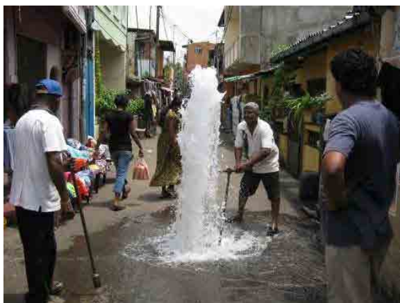
Kotahena 水理的分断作業
