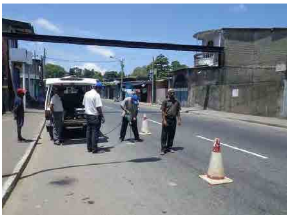
パイロット活動（Kotahena） （漏水箇所の掘削）
