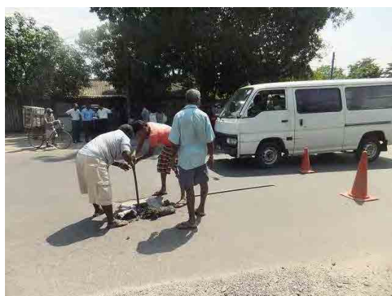
パイロット活動（Kotahena） （水理的分断作業）
