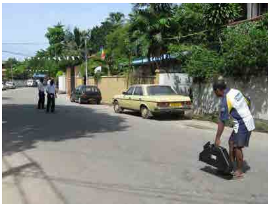
Borella 管路埋設位置探査
