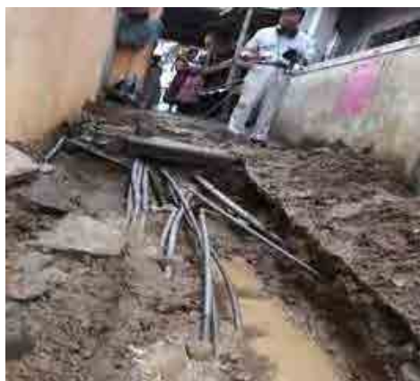
パイロット活動（Kotahena） （束状給水管(Bundle Pipe)の撤去作業）
