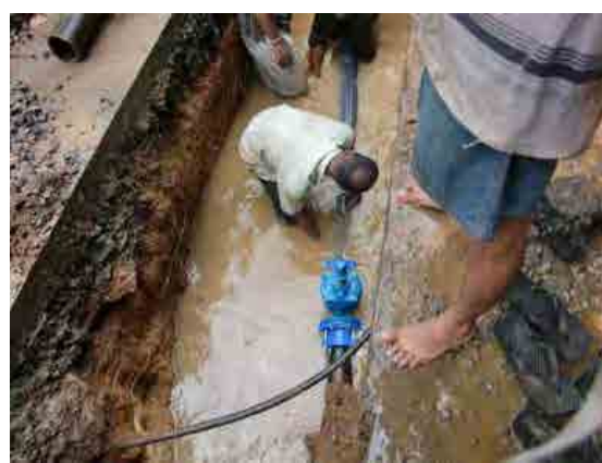
Borella バルブ設置
