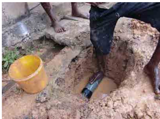
Borella 漏水補修
