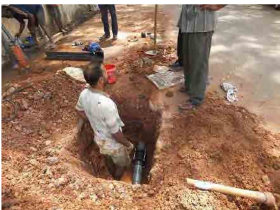
パイロット活動（Borella） （漏水修理状況）
