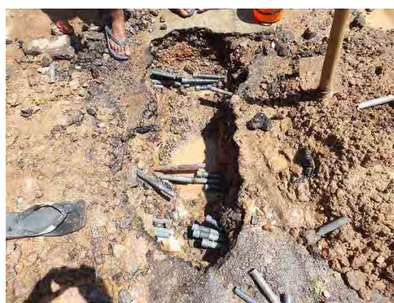
パイロット活動（Kotahena） （束状給水管(Bundle Pipe)の撤去作業）
