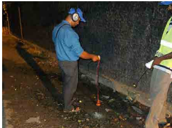
パイロット活動 （夜間の漏水調査状況）
