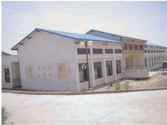
中国の支援により建設された初等学校の外観 (シルティエ県ワラベタウン内)
