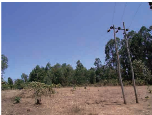
S-4 建設サイトの様子（電線の移設が必要）
