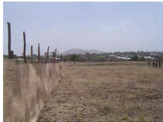
S-10 建設サイトの様子（左側は初等学校）
