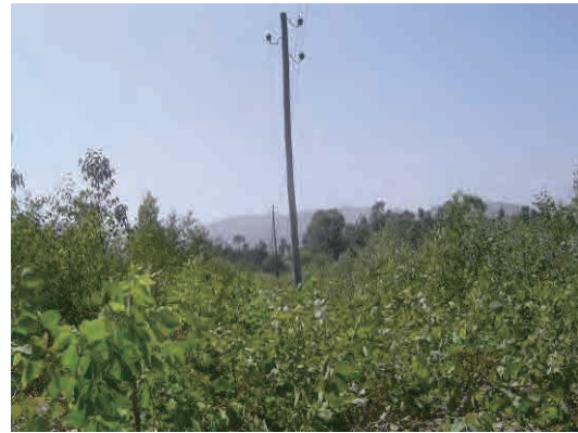
S-8 建設サイトの様子
