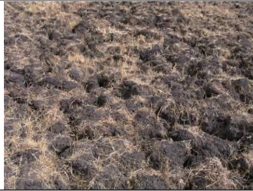
S-6 建設サイトの土質（膨張土）
