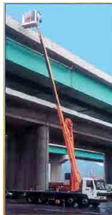
図 5-25 橋梁点検車・高所作業車を用いた点検の例
