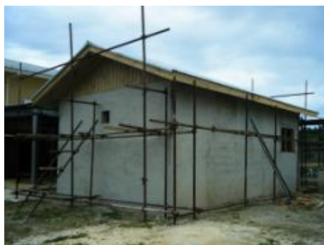
図 5-15 CT 装置用建物
