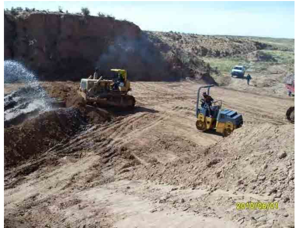
ラパス県サン・ペドロ・デ・クラワラ市 Untu Chico Bajo 村落 (せき止め池建設現場)
