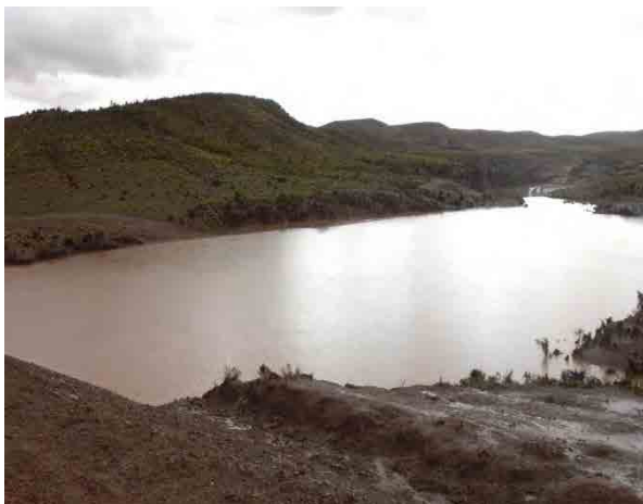
ラパス県ウマラ市 Chapicollo 村落 (せき止め池)
