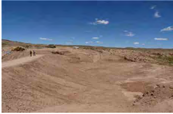
Chapicollo 村落（堤体）
