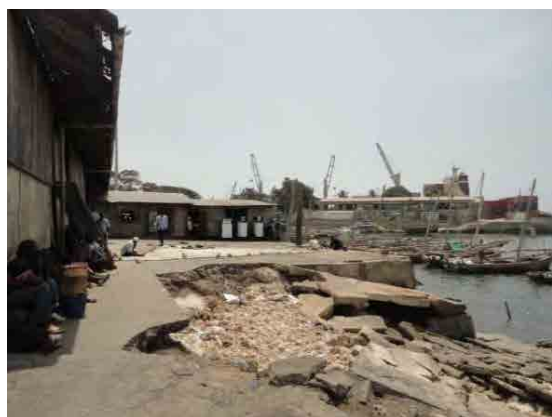
(5) 船舶用燃料スタンド3基（正面突き当たり）
