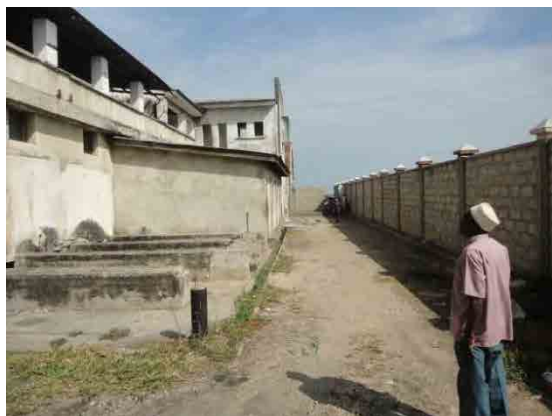
(3) 現在の Lot A（旧 ZAFICO の放棄された施設）
