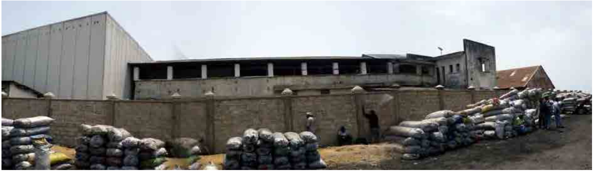
旧国営漁業公社の水産加工施設の跡 Lot“A” (ブロック塀の手前は、Lot“B”食用油貯蔵施設予定地、木炭の野積み場となっている)
