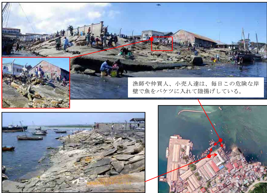
図3-19 スロープ式係船岸の現況
