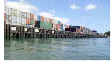
ザンジバル・マリンディ港（商港の West Wharf は水深 11m、手前は旅客船用の浮き棧橋）
