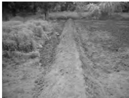
Photo : Aplanissement de parcelle et construction de la diguette
