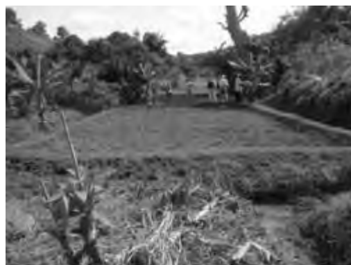
Photo : Après la construction de la diguette (le 22 juin 2009)
