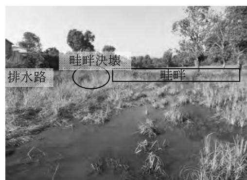
修復されていない畦畔
