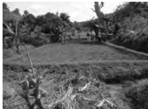
畦畔築堤後 2009年6月22日撮影
