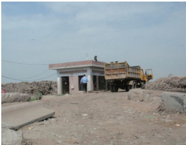
写真 3-48 メムード・ブティ最終処分場 入口の管理棟
