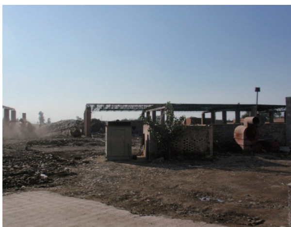
写真 3－46 Waste Busters 社敷地内に建設中の処理工場
