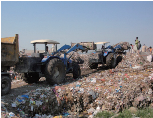
写真 3-19 チアンワリ最終処分場（3） （入口付近の廃棄物の敷き均し）
