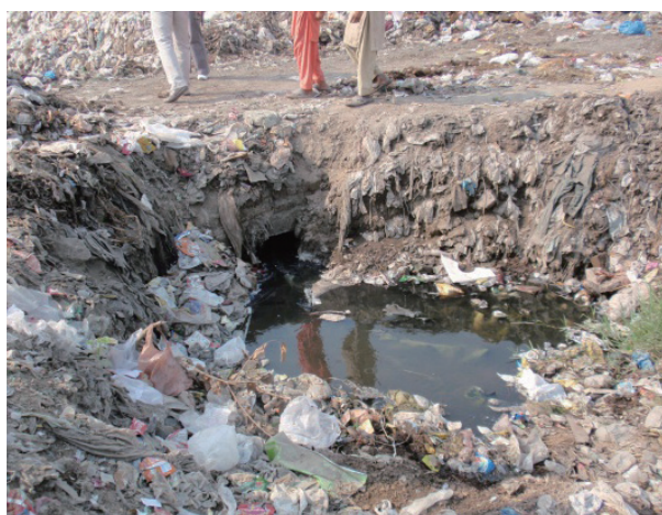
写真 3-21 チアンワリ最終処分場（5） （入口付近で滞留する浸出水）
