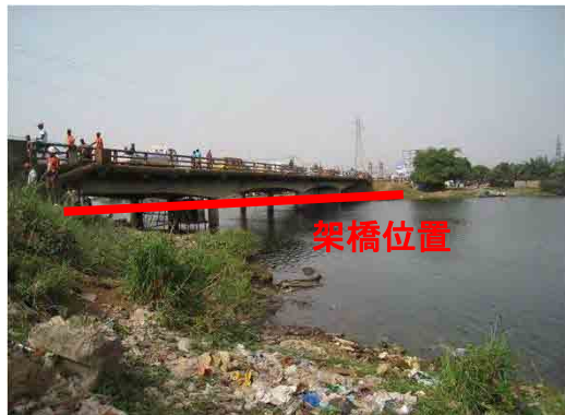
ストックトン橋架橋位置 既存ストックトン橋に水道管(16インチ)が添架されて おり、新設ストックトン橋を構築する際には、埋設部 も含めて移設が必要となる。
