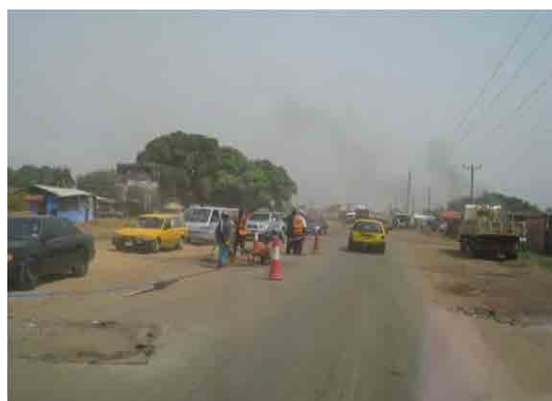
写真 2.1-1 道路補修状況
