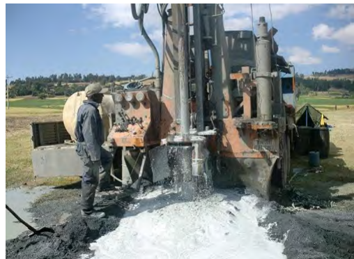
試掘調査（掘削）
