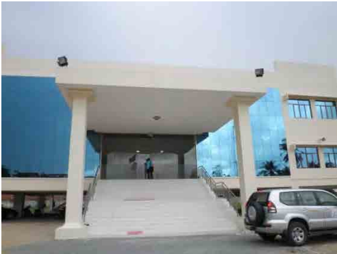
中央給電指令所（NCC）全景
