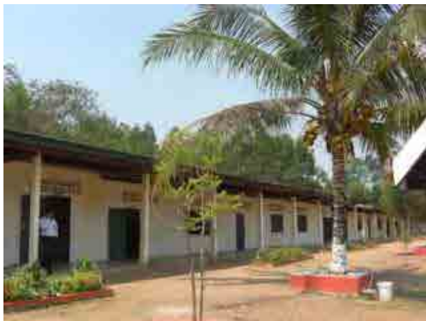
サバナケット県カイソン郡タートインハン小学校の校舎
