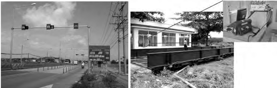
Hình 5.62 Hệ thống WIM (bên trái) / Hệ thống Cân tĩnh (bên phải) / Cầu Cân tĩnh (Dưới)
