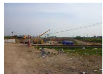
Công tác đào đắp Tuyến NB-VT
