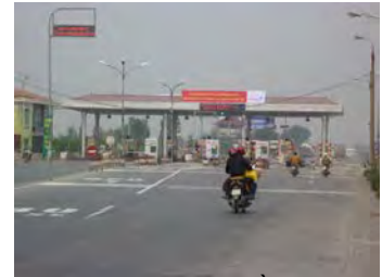
Trạm thu phí tại Cầu Giẽ
