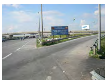
Nút giao tại Nội Bài
