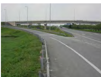
Nút giao tại Bắc Ninh
