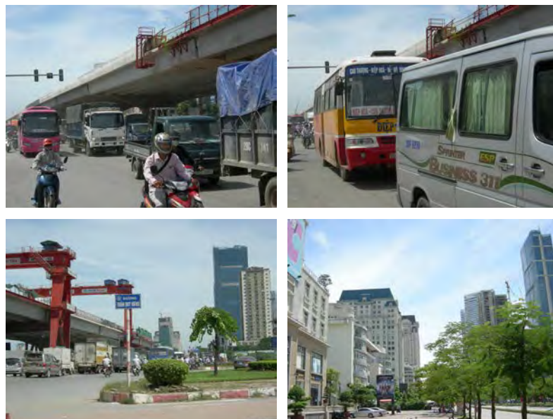
Hình 3.14 Hiện trạng Giao thông Đoạn tuyến Tây Nam Đường Vành đai 3
