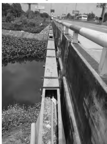
STA6+300 Van Tri Bridge
